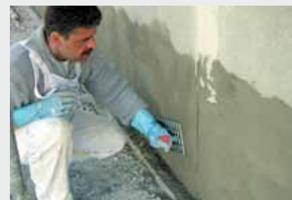
14.30 Uhr – Die Fläche kann bereits nach ca. 1,5 Stunden abgegittert werden.
