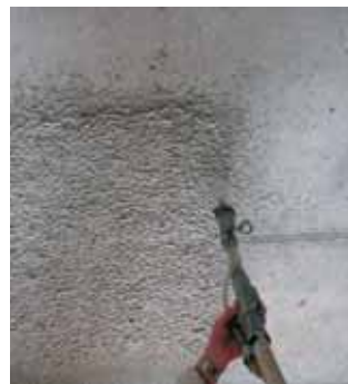
Spritzen einer Betondecke
