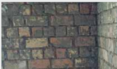
Mauerwerk in einem Altbau mit großen Unebenheiten (unterschiedliche Putzdicken erforderlich).
